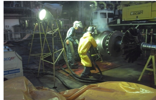
Reinigung von Gasturbinen
