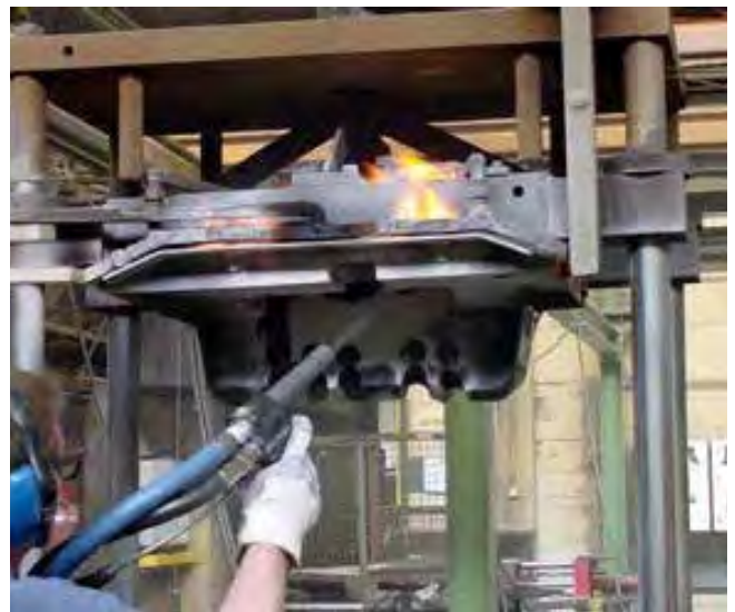
Bild 1: Kokillenreinigung in heissem Zustand
