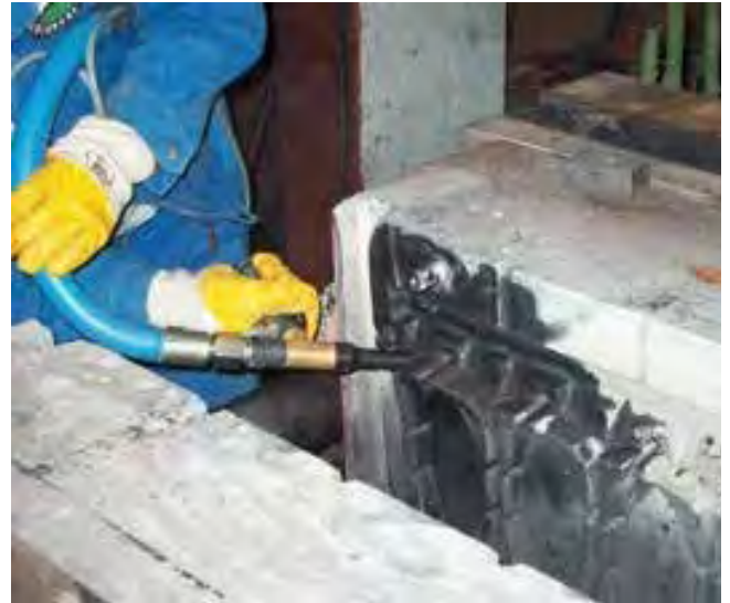
Bild 3: Reinigung einer heissen Kokille im eingebauten Zustand
